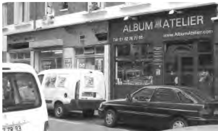
Nette différence entre une devanture rénovée et une non-rénovée
